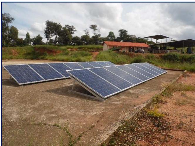
Painéis fotovoltaicos. 8 kwh/dia de energia produzida por um total de 6.500 kw h por ano evitando a emissão de 6 t. de carbono na atmosfera
