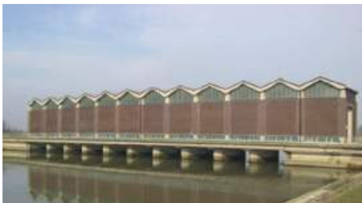
Immagine 01 - L’Impianto Idrovoro Lepri Acque Alte (FE), con una portata di 117 m 3 /s, è il più grande idrovoro d’Europa e avvia al mare tutte le acque che prima della bonifica si riversavano nella valle del Mezzano.
