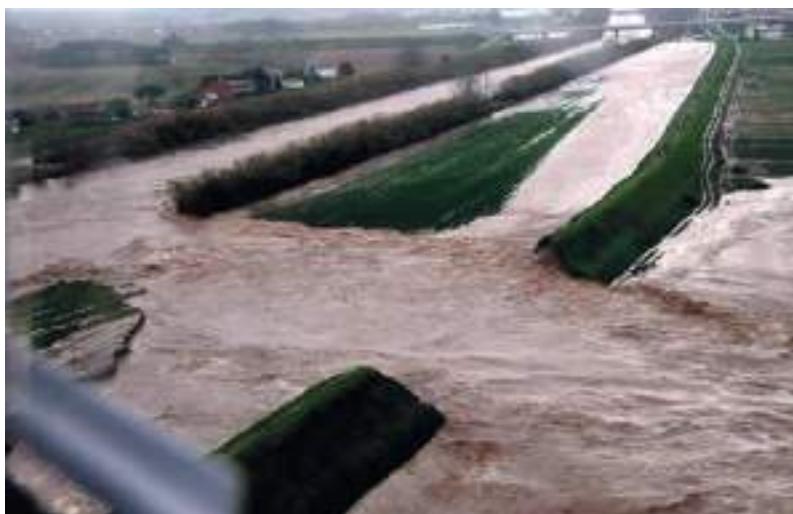
Immagine 07 - La rotta dell'argine del Fiume Serchio in occasione dell'evento alluvionale del dicembre 2009.
